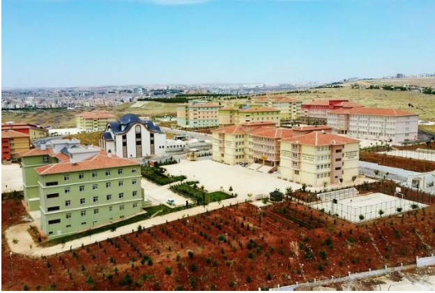
Okul ve Pansiyon Binası
